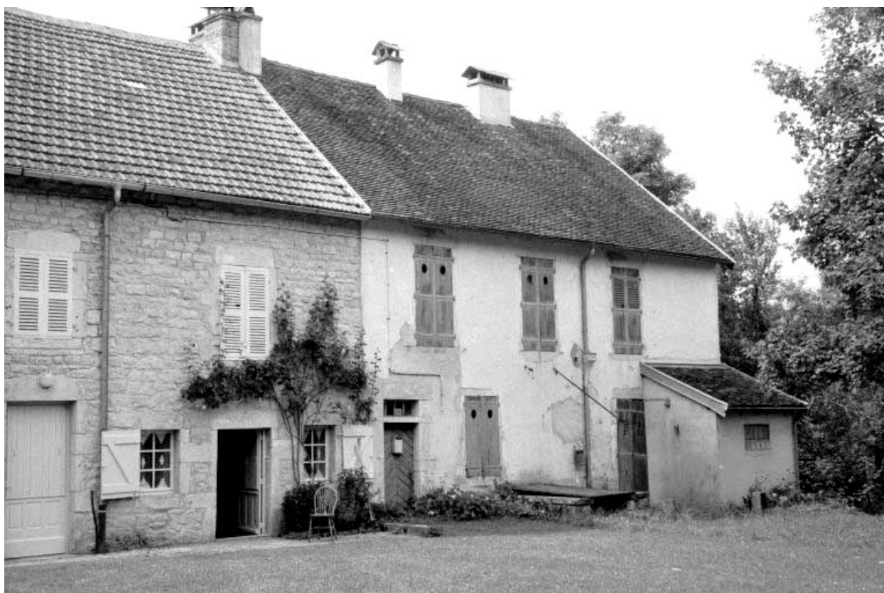
Façade postérieure du logement.
