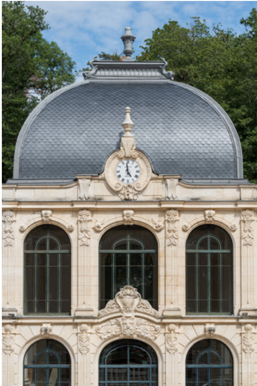
Pavillon central, vue de face, détail.
