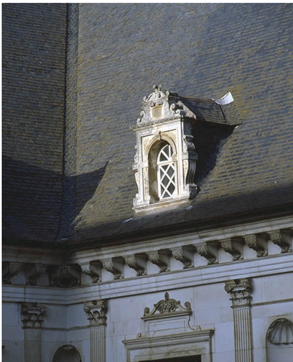
Façade sur cour, détail : lucarne
