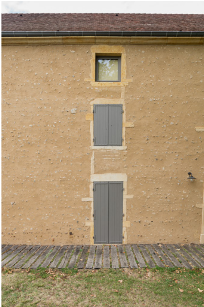
Travée de la façade antérieure de la maison
