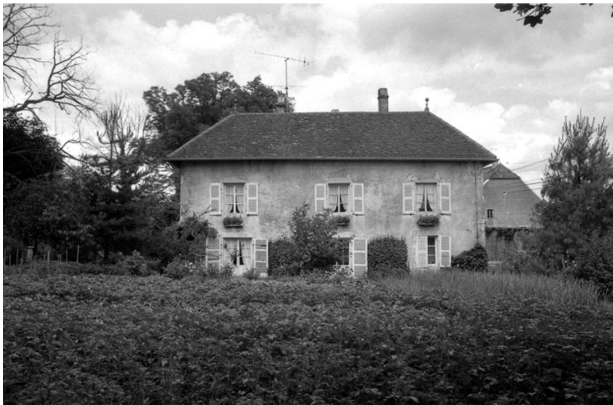
Façade postérieure de l'habitation.
