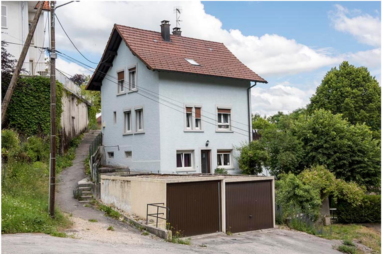
Maison : façades postérieure et latérale droite.
