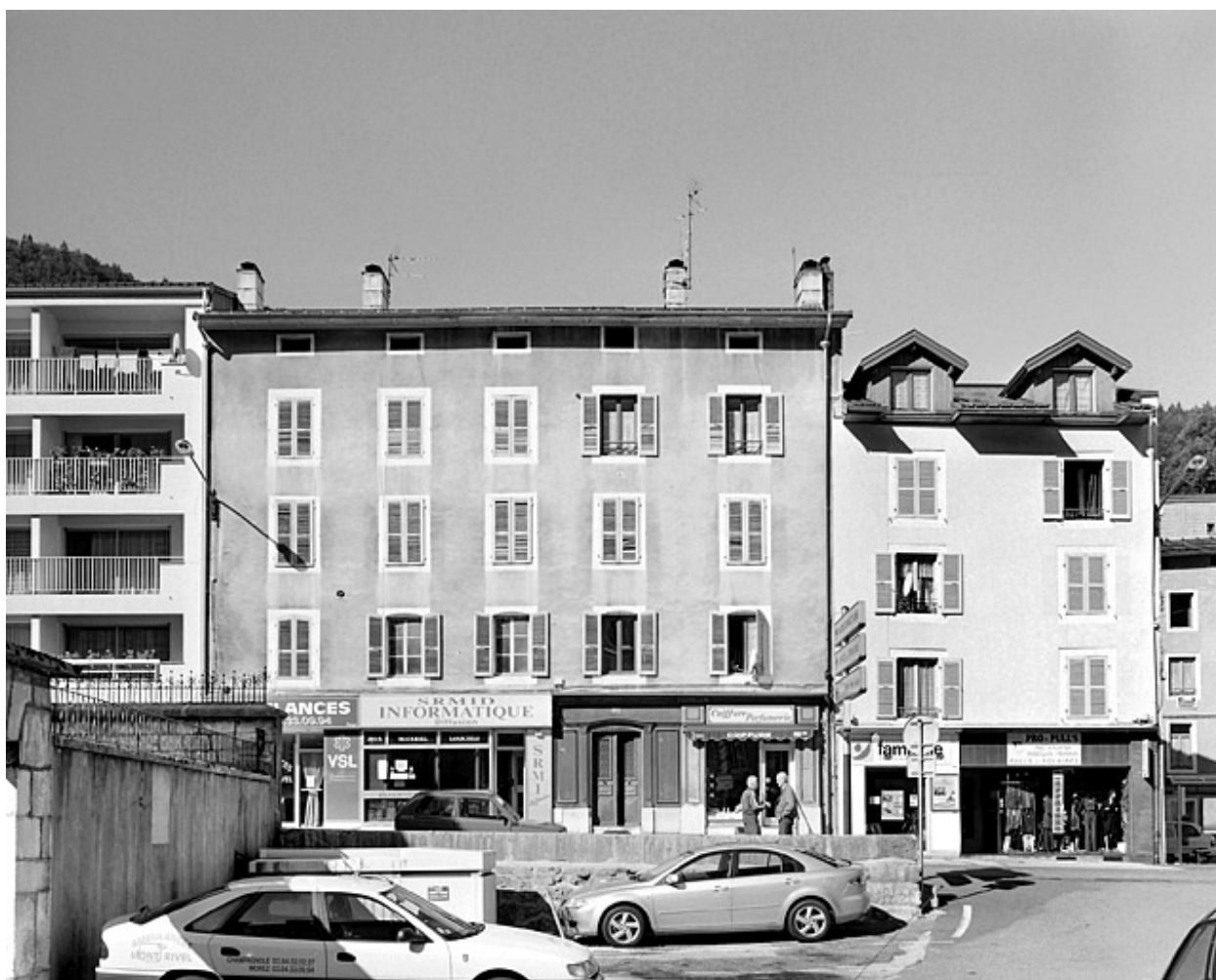
Vue d'ensemble de l'élévation antérieure.
