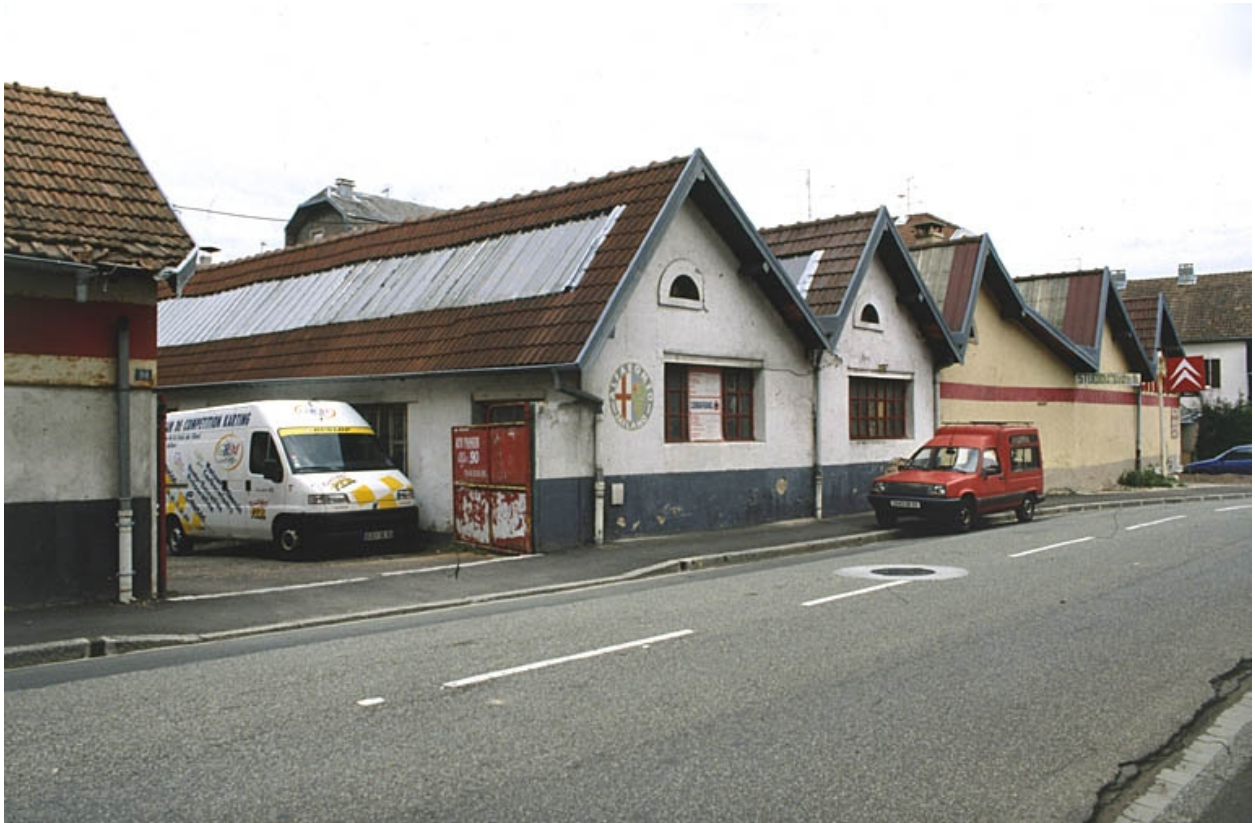
Pignons des ateliers depuis le nord-ouest.
