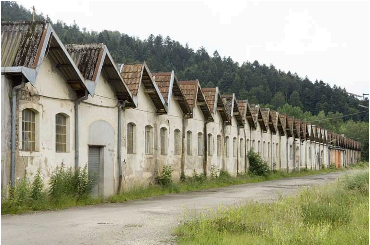
Atelier de fabrication. Alignement de pignons de sheds.
