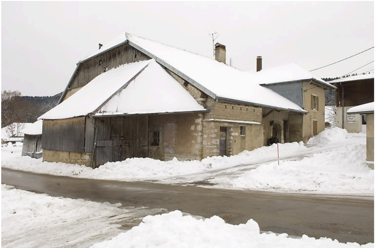
Façades antérieure et latérale gauche.
