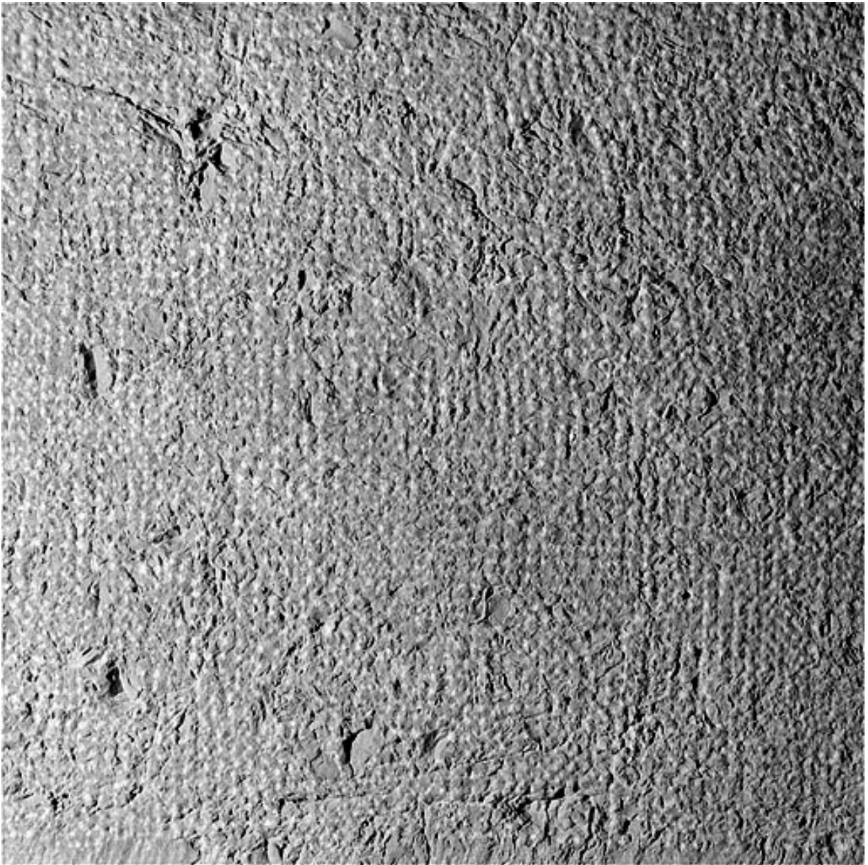
Traces de boucharde sur la pile IS.
