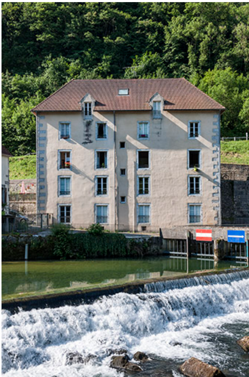
Façade nord d'un logement d'ouvriers.
