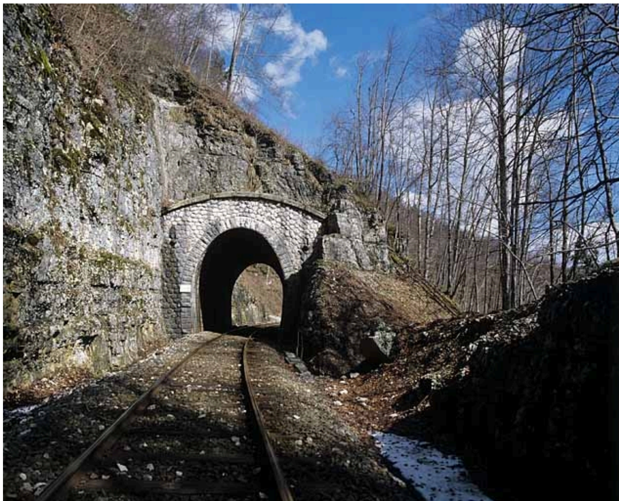
Vue d'ensemble, côté La Cluse (sud).
