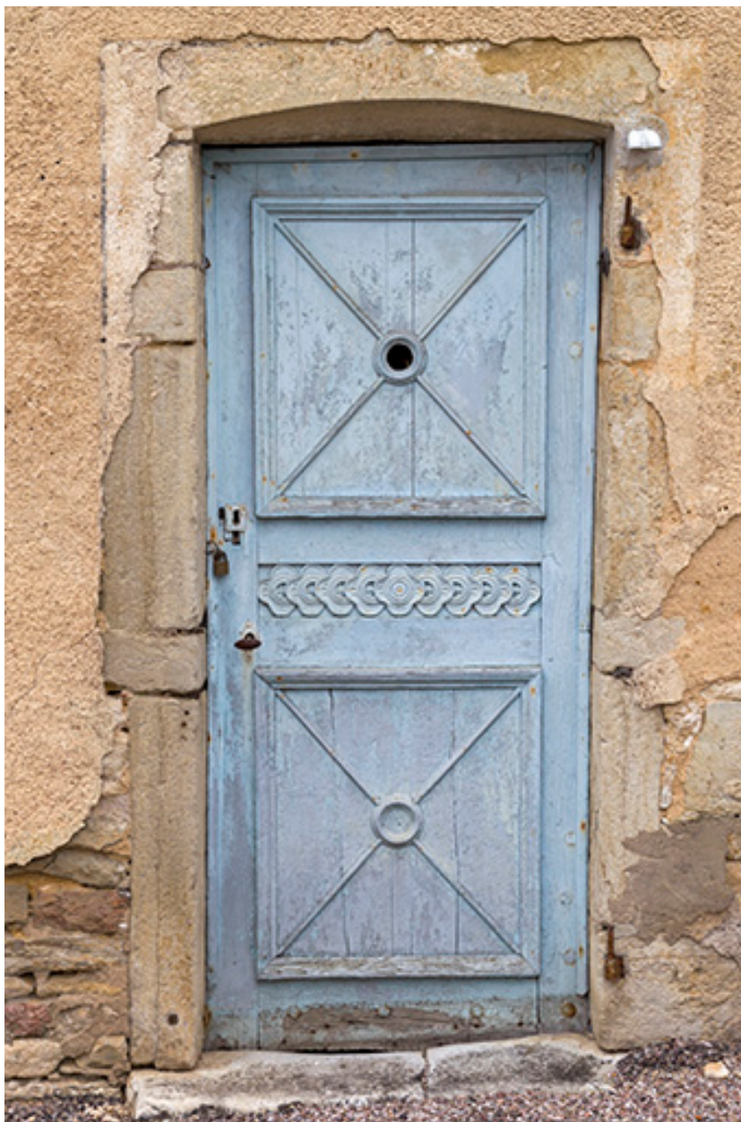
Ferme 5 rue du Château : porte du logis.
