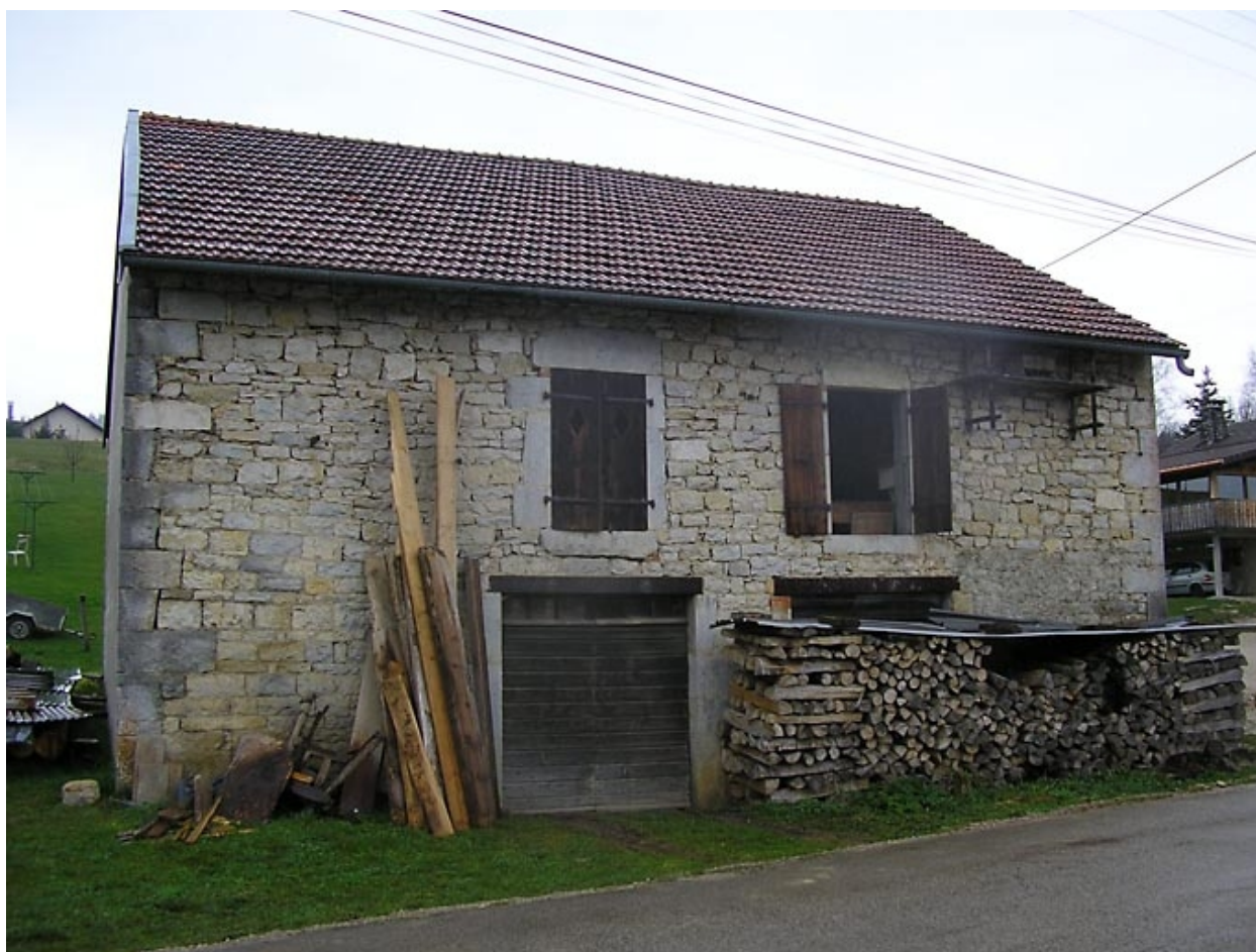
Vue générale sur façade antérieure.
