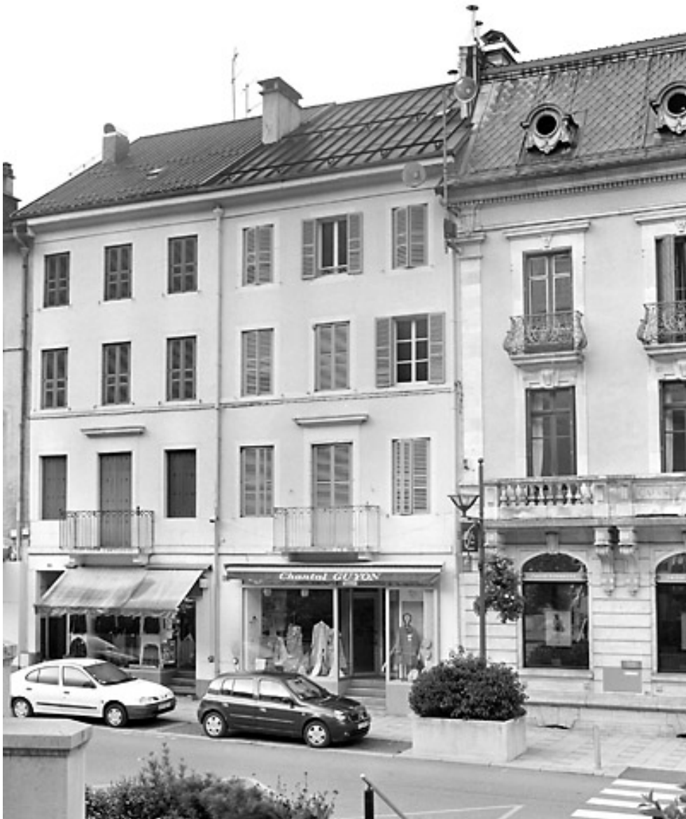
Elévation antérieure, de trois quarts droite.
