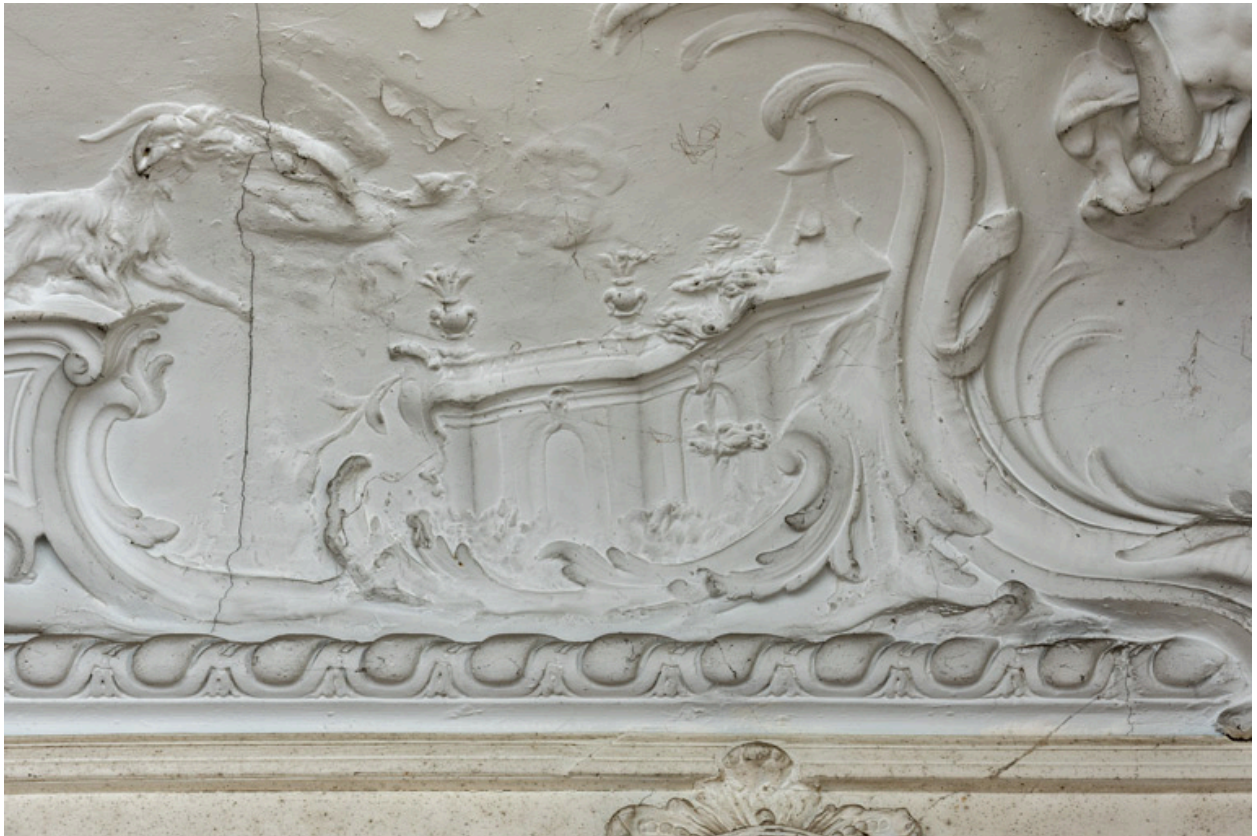
Salon du rez-de-chaussée, plafond, décor sculpté, détail : édifice.
