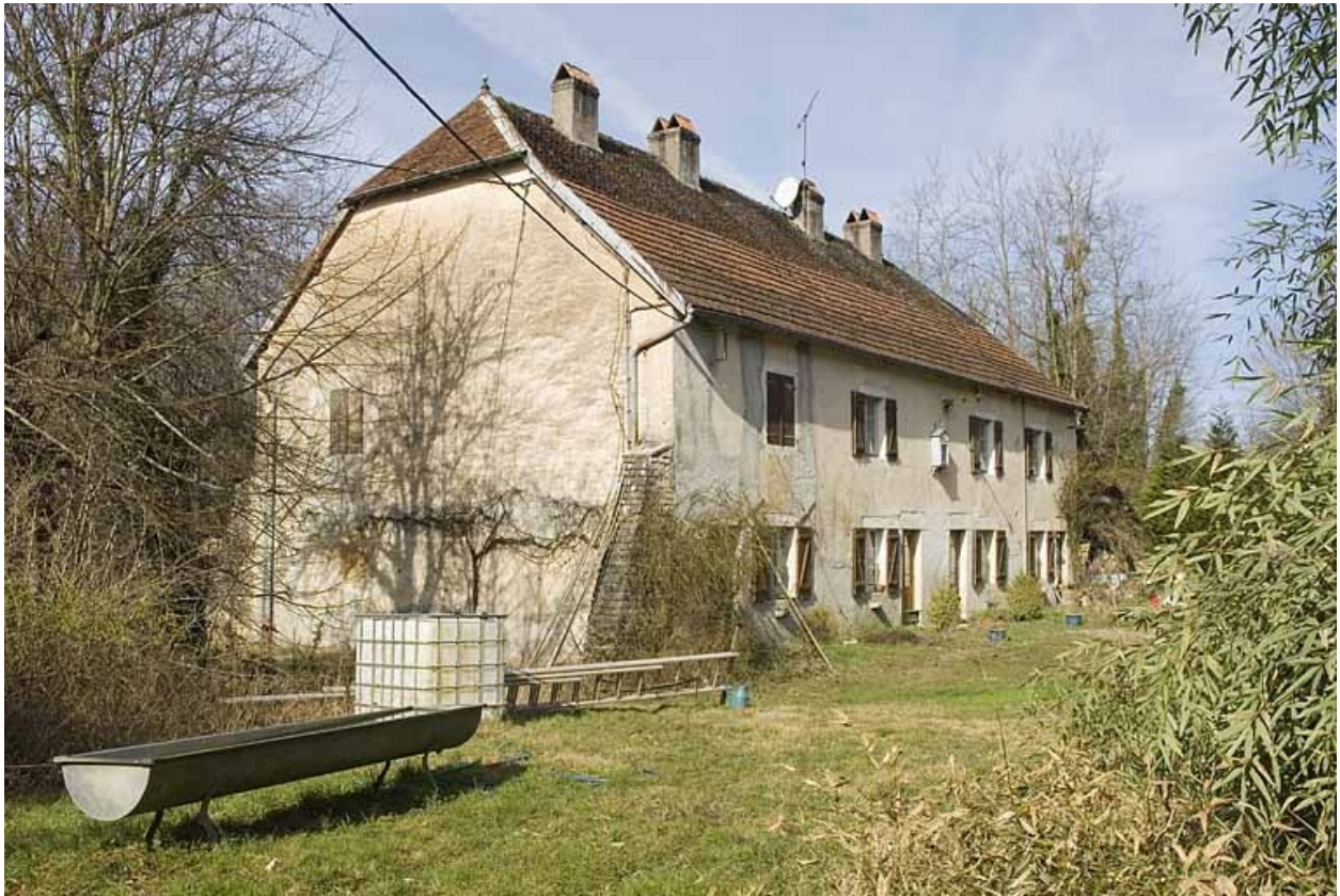
Logement d'ouvriers. Vue de trois quarts.
