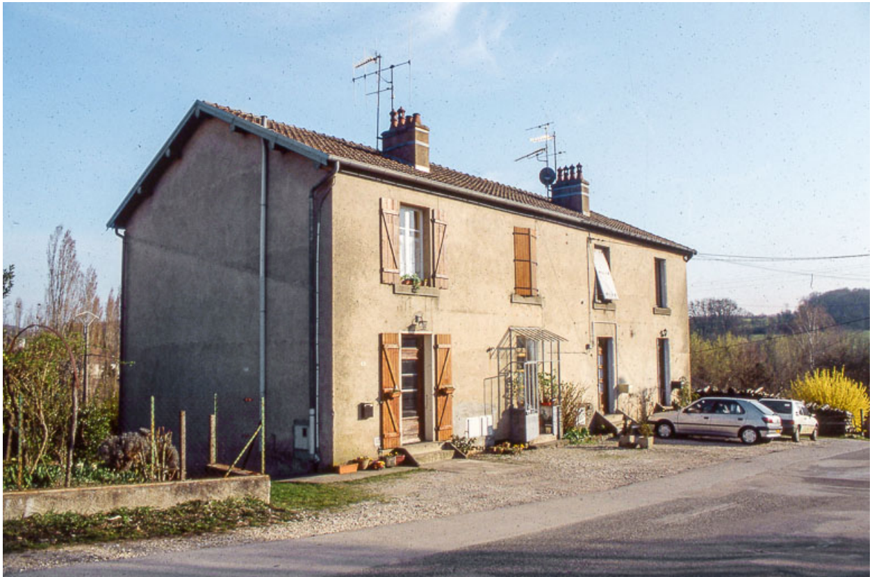
Logement d'ouvriers (9 rue des Saulniers).
