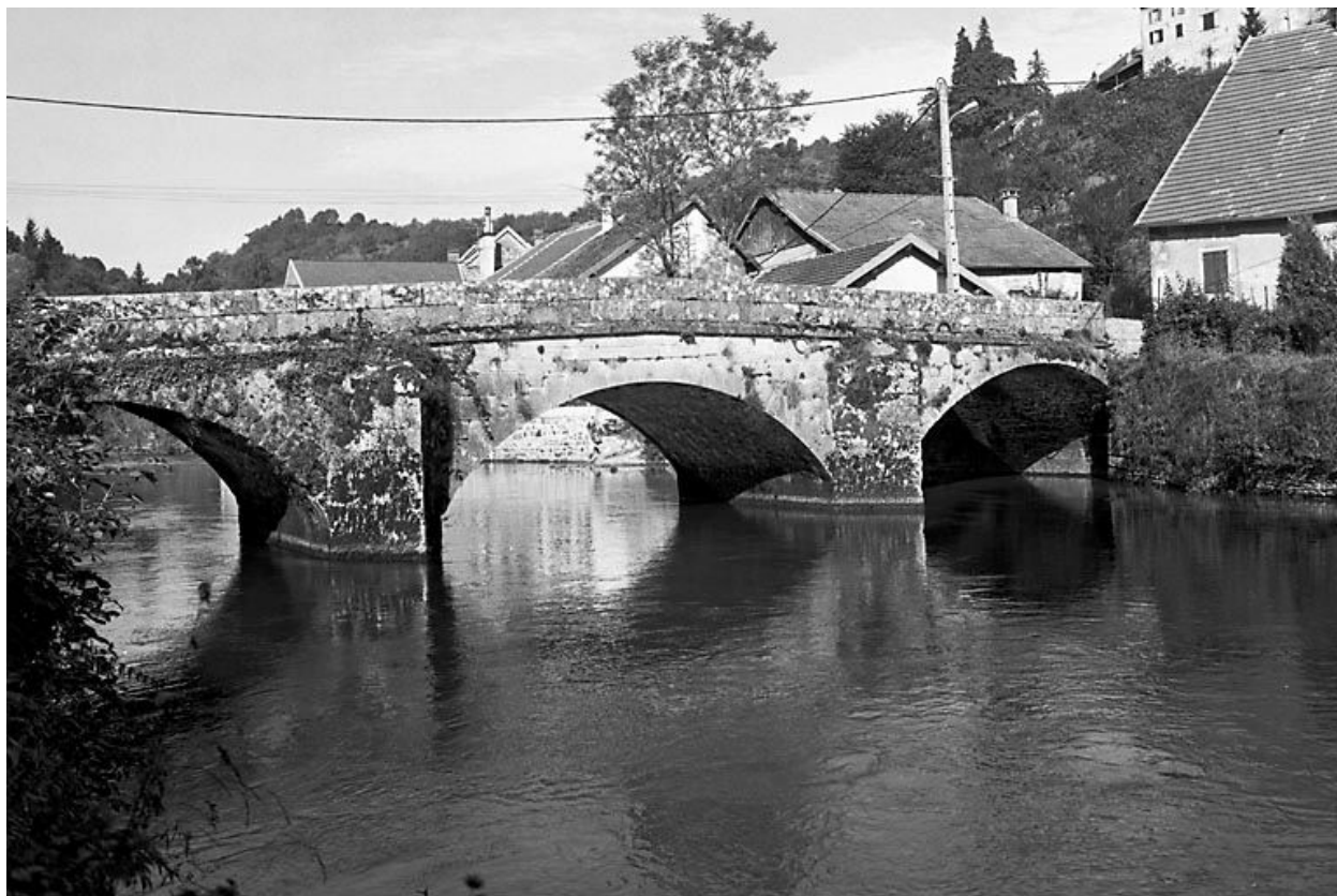
Vue depuis l'amont.
