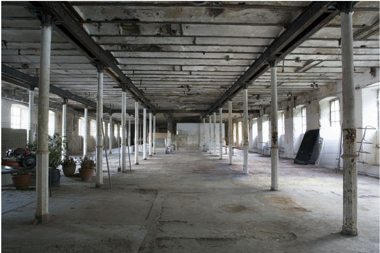
Atelier de préparation de la pâte. Vue du rez-de-chaussée depuis le sud.
