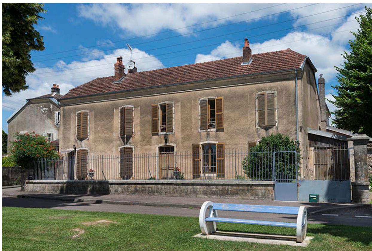
La façade antérieure.
