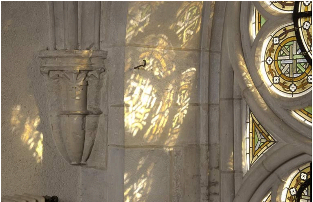
Bâtiment du réfectoire : culot fasciculé à chapiteaux feuillagés (13e siècle).
