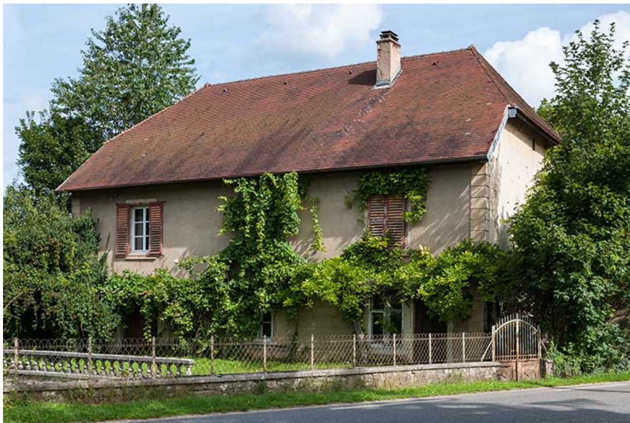
Façade sud : le logement.
