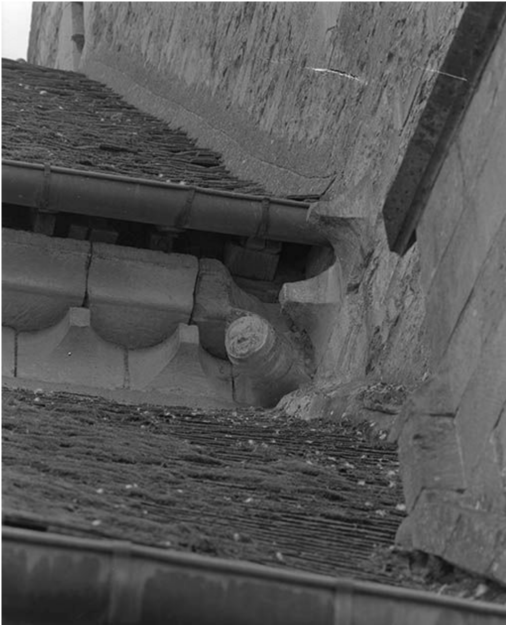
Choeur, détail de la tête ornant la corniche gauche, dans l'angle formé avec la nef.
