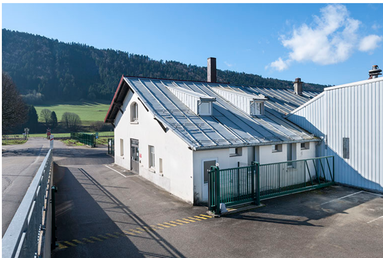
Partie sud du bâtiment originel (bureaux).
