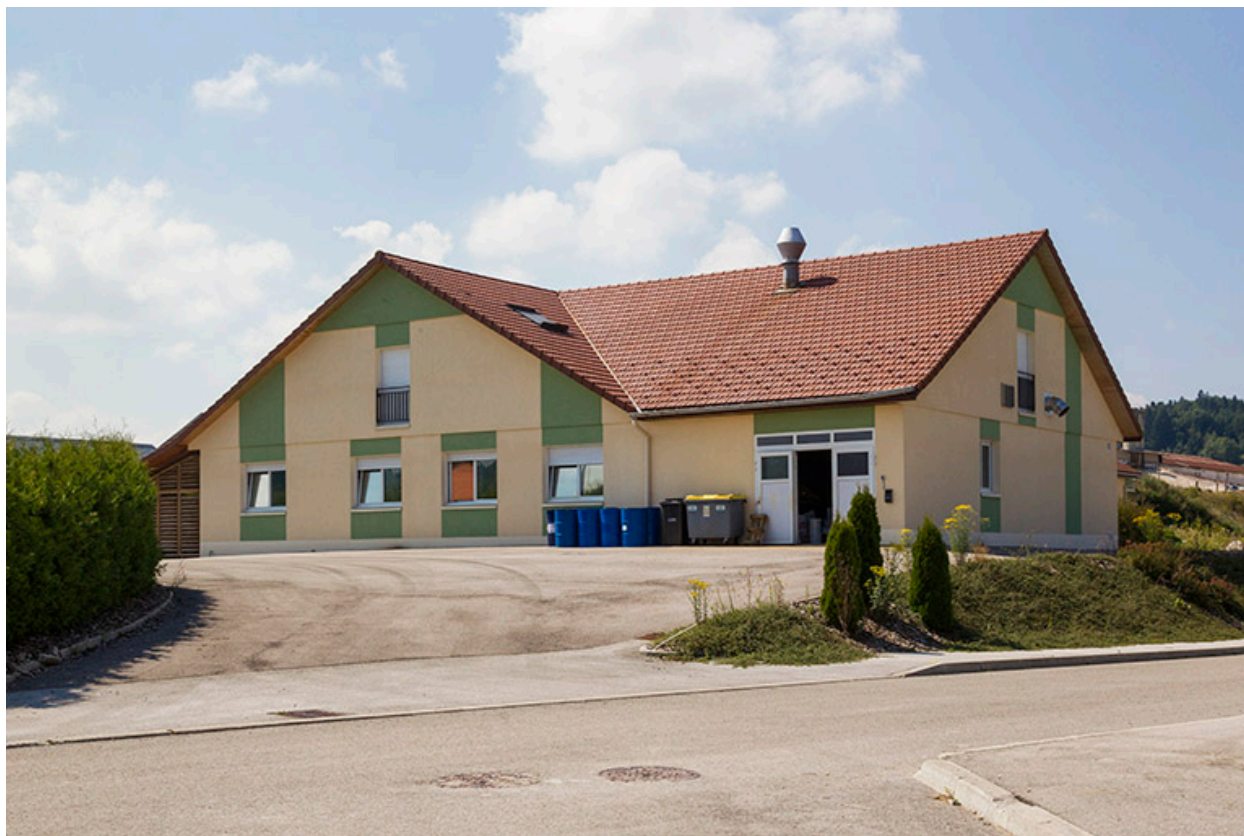
Façades postérieure et latérale gauche.
