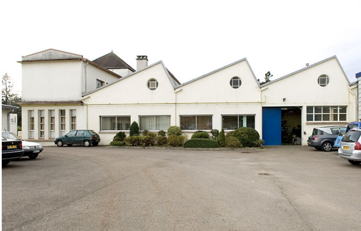
Murs-pignons de l'atelier de fabrication.
