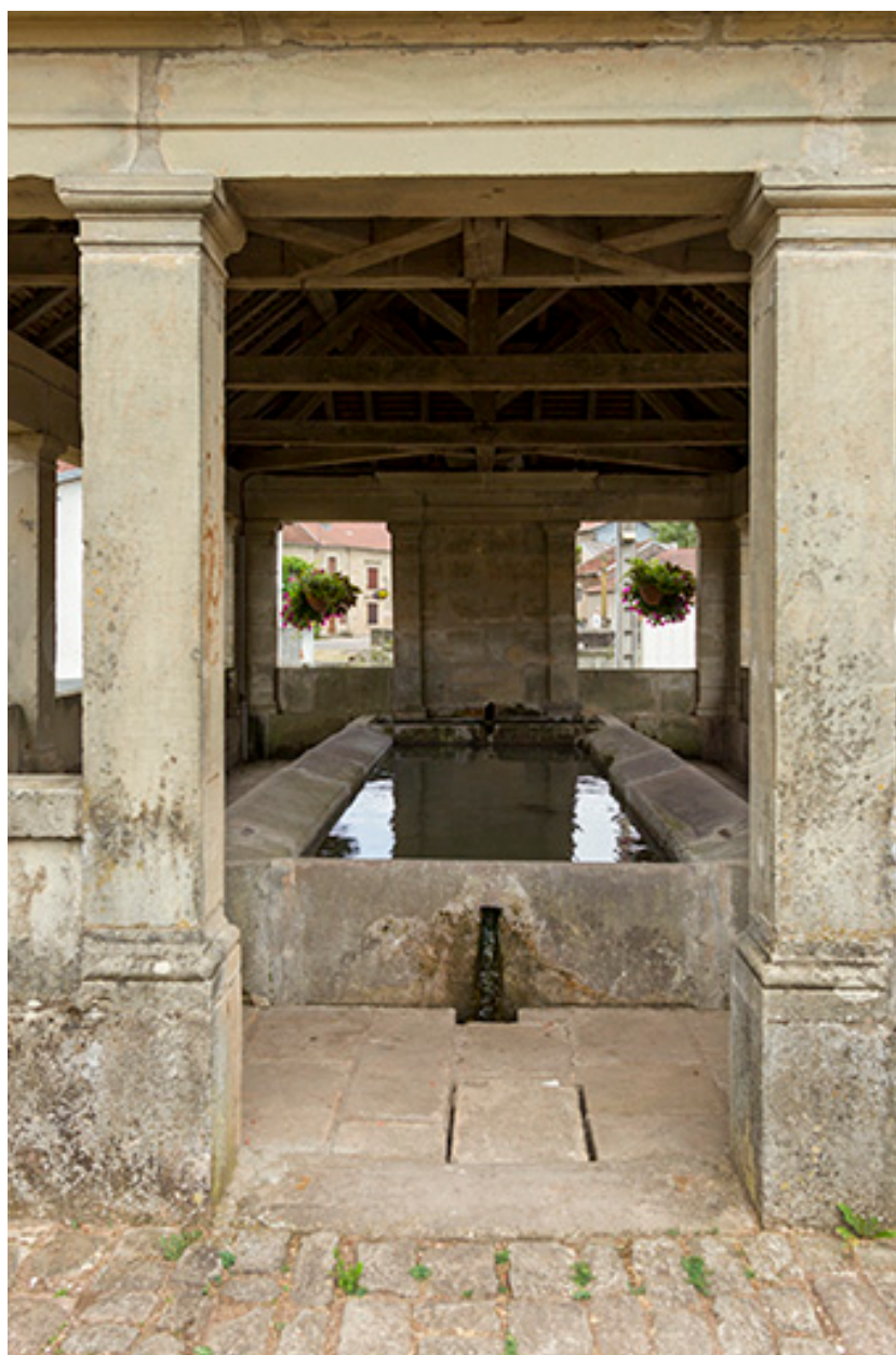
Vue sur le bassin intérieur.
