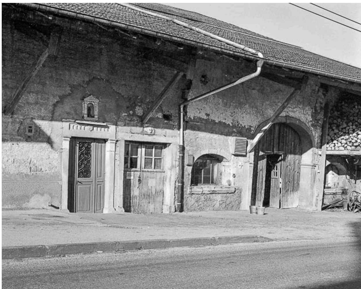
Détail de la façade sur rue.
