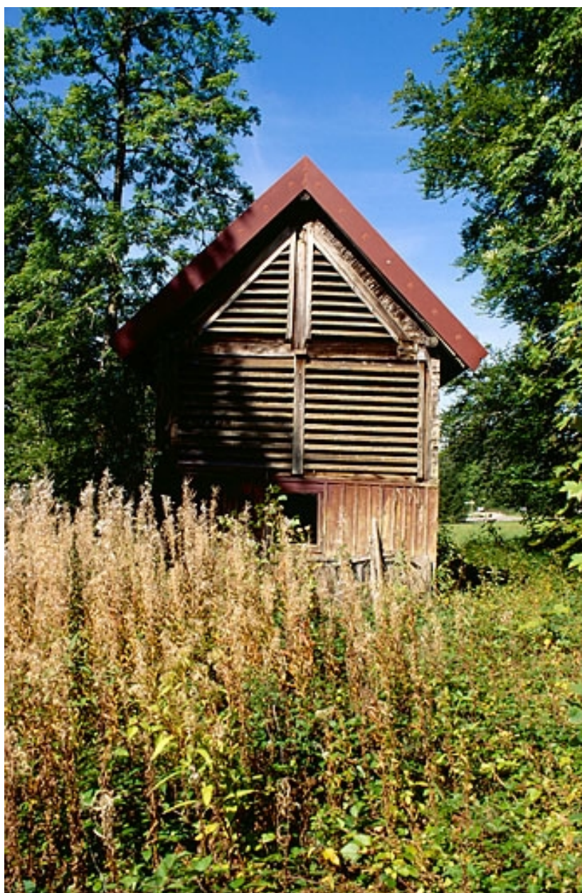
Façade sud du hangar séchoir.
