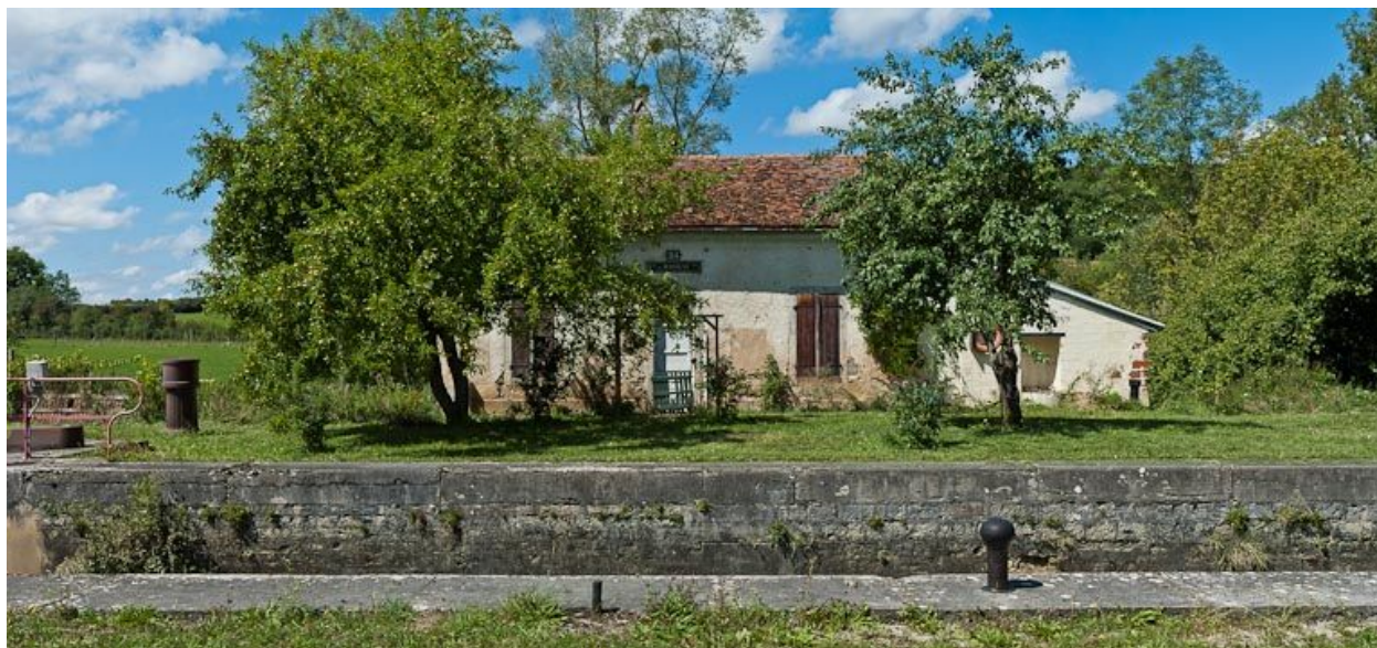
Vue de face de la maison éclusière.
