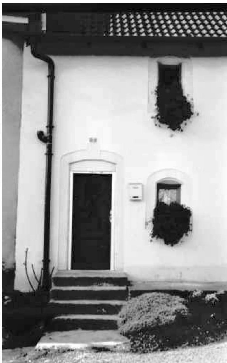
Façade antérieure : détail.
