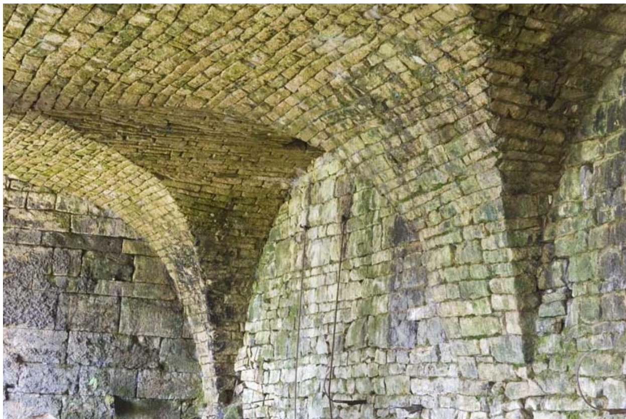
Salle des cubilots. Détail des voûtes d'arêtes.
