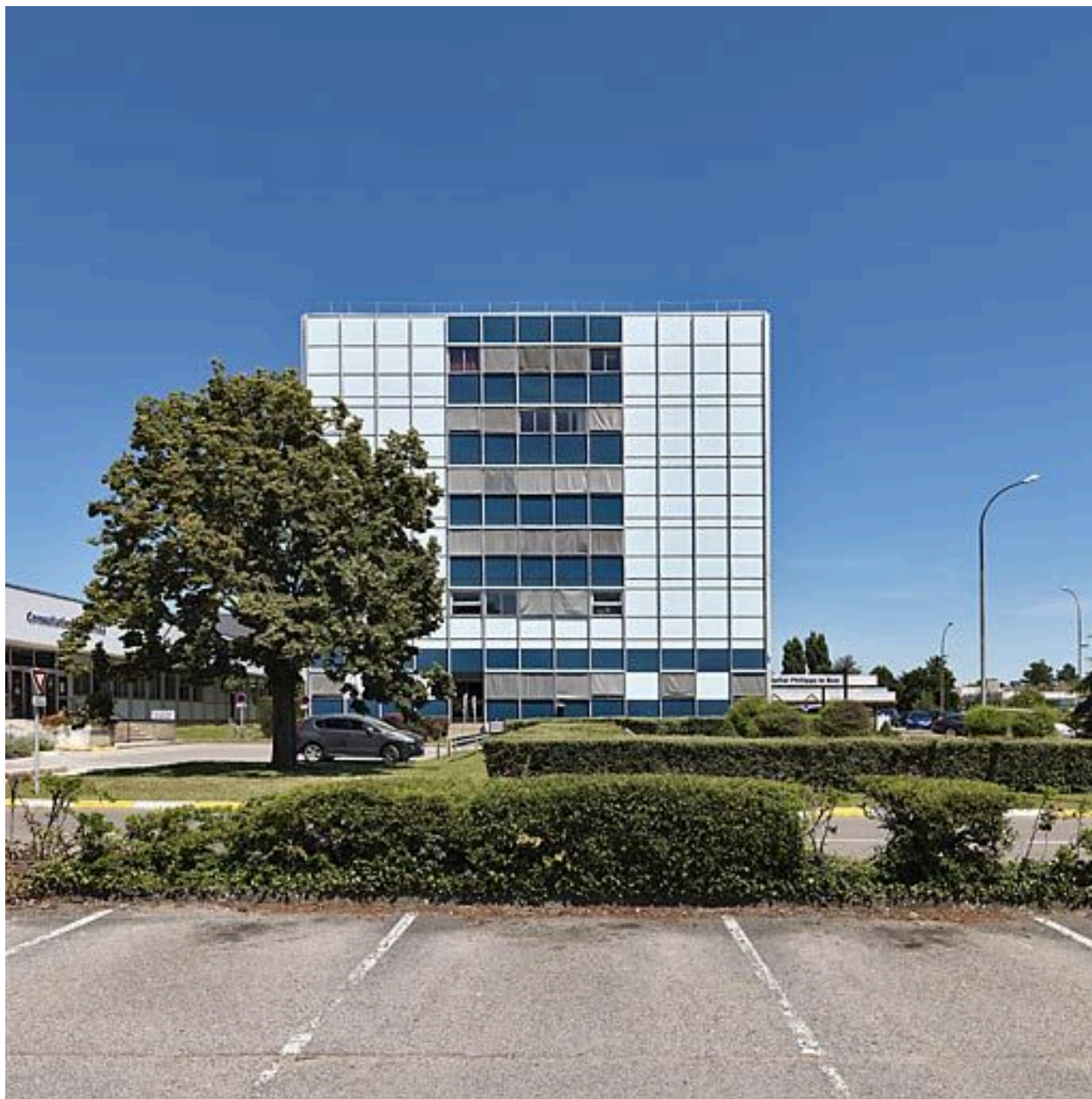
Bâtiment principal, élévation latérale.
