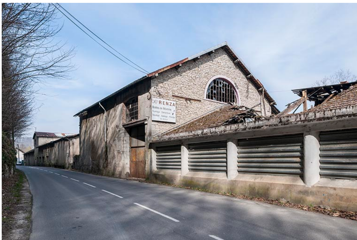
Route des Papetiers : chaufferie et magasin industriel.
