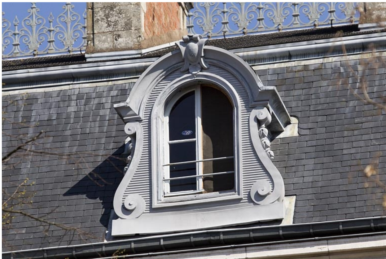
Toiture : détail d'une lucarne.
