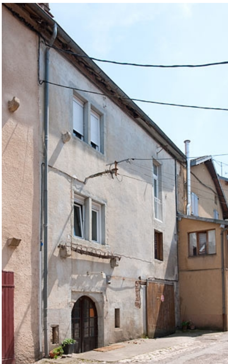
Ferme au 10 Grande Rue (2010 AL 46) : façade postérieure (rue Basse).
