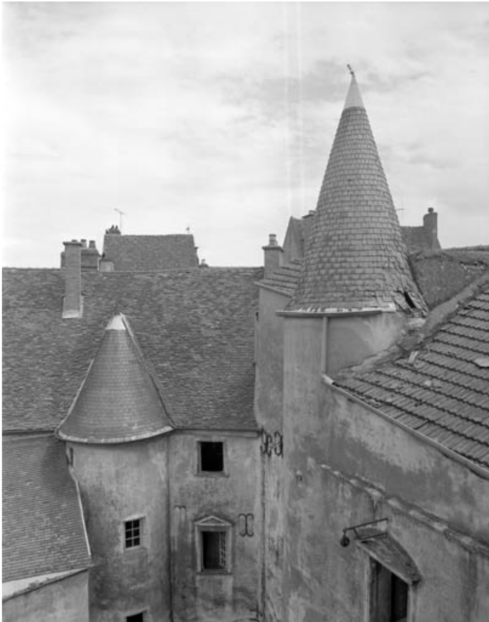
Bâtiment droit : vue des toitures, depuis la cellule de saint Pierre Fourier.
