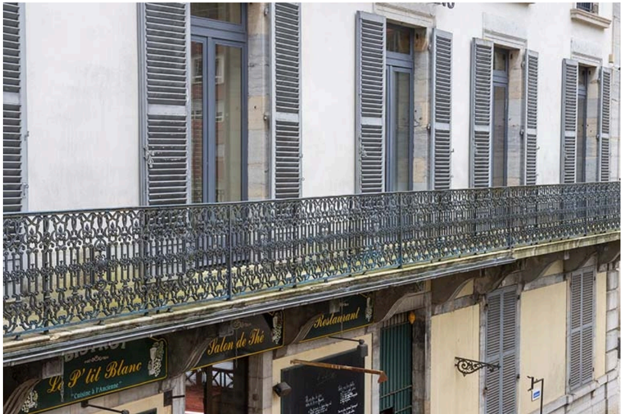
Façade nord, balcon.
