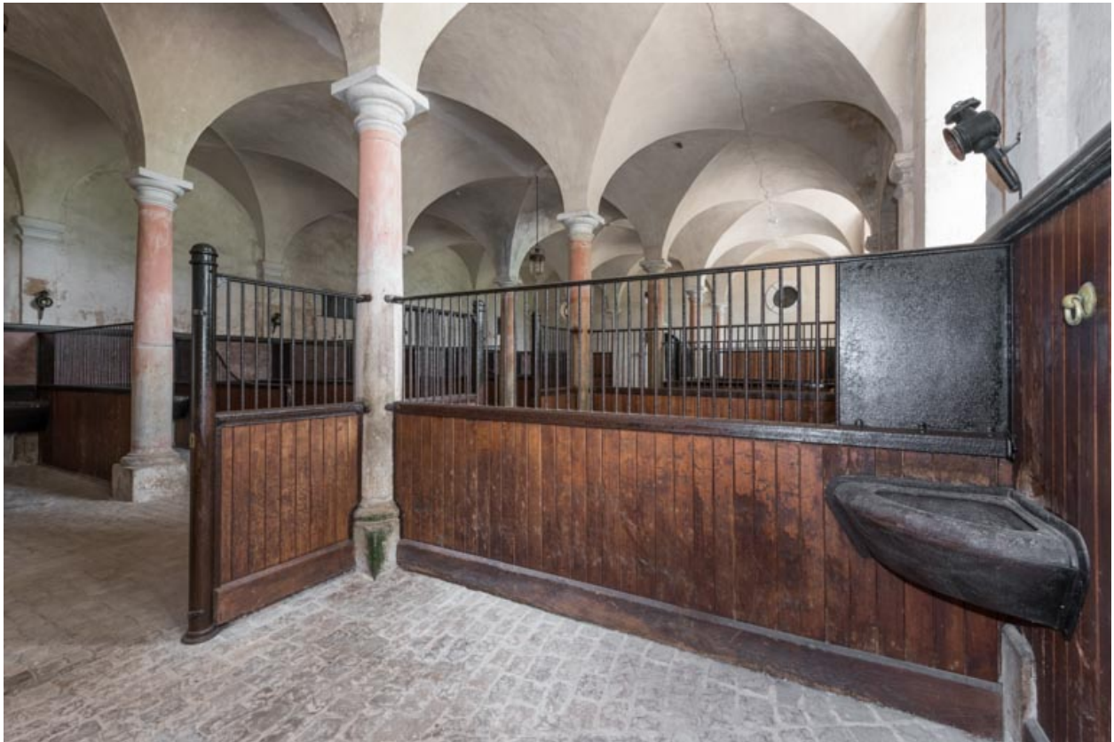
Rez-de-chaussée, salle centrale, boxes contre le mur sud-est.
