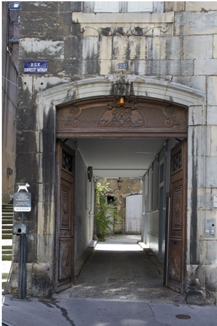
Logis principal : détail du passage cocher depuis la rue.
