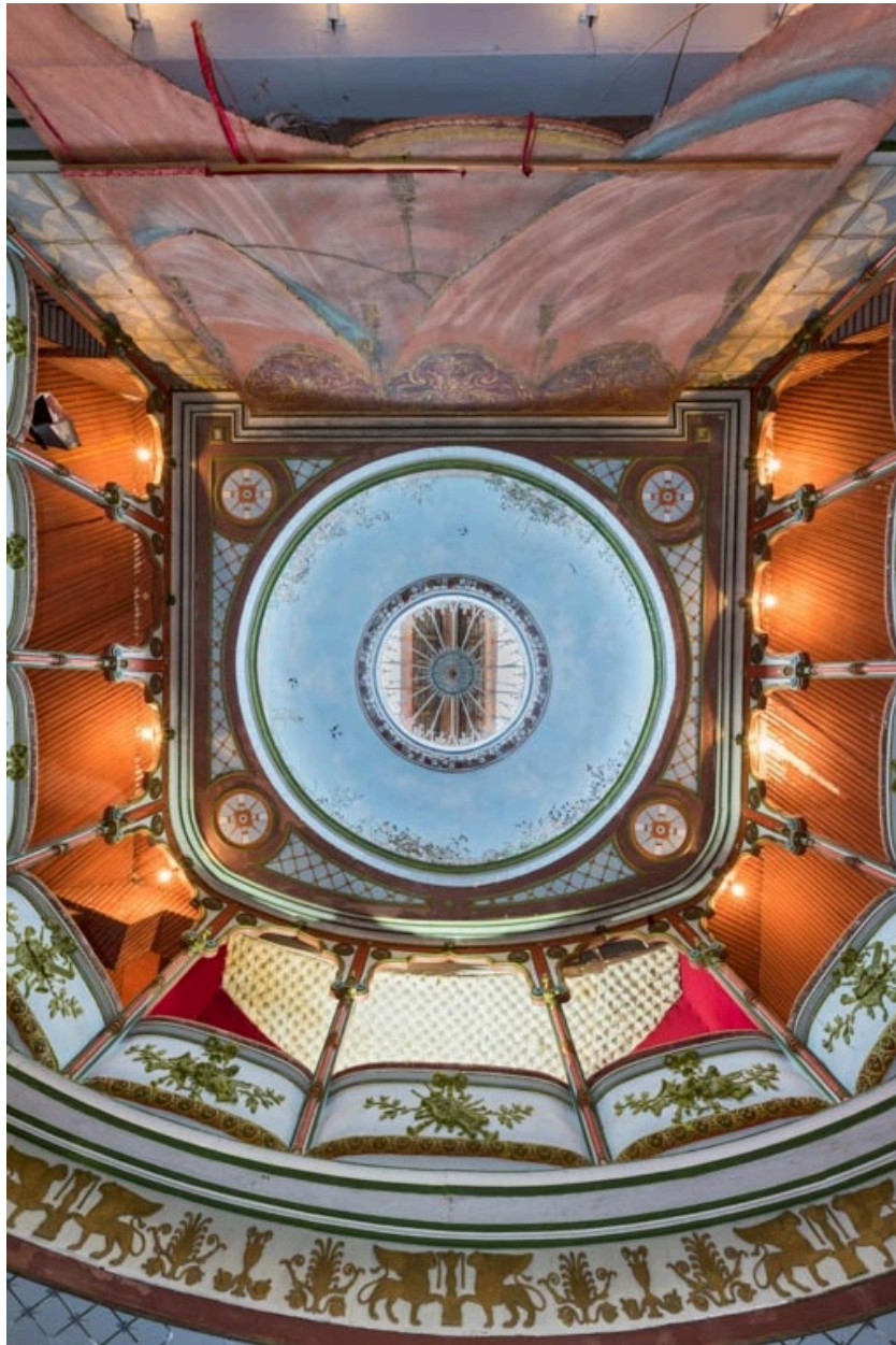
Salle : vue d'ensemble du balcon et du plafond.
