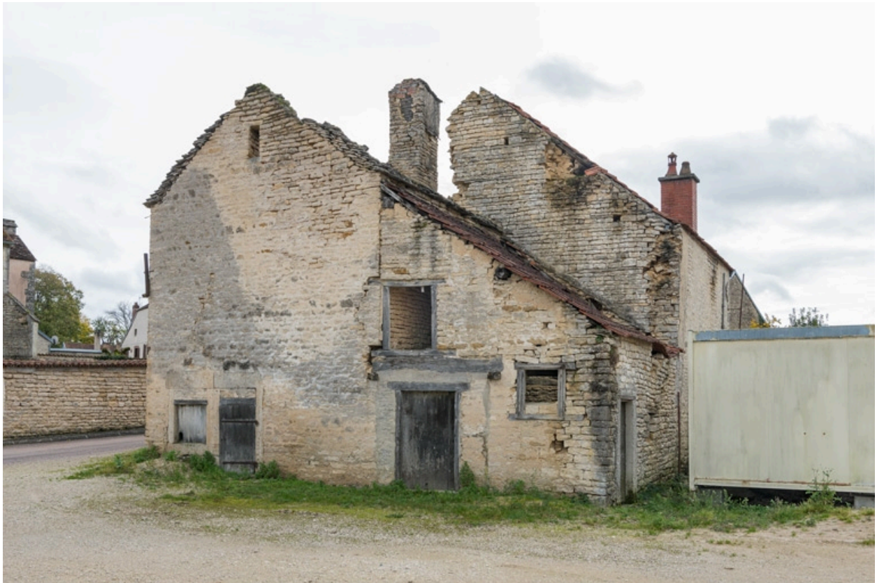
Vue du mur pignon sud.
