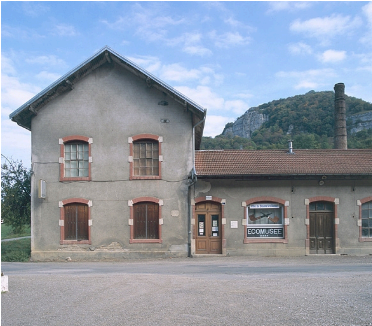
Façade antérieure du bâtiment à étage.
