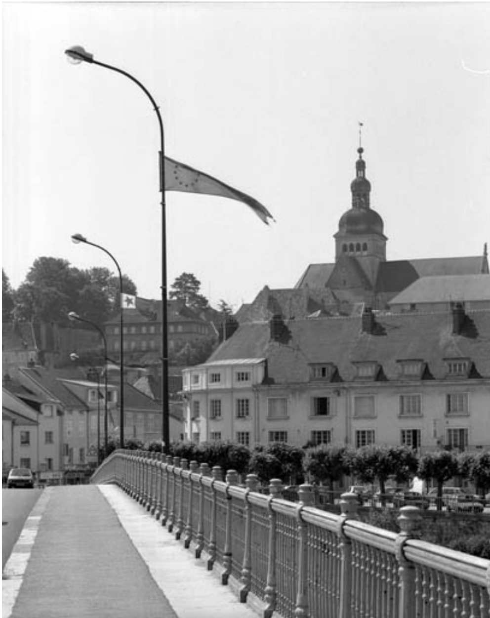
Vue du garde-corps en fonte.
