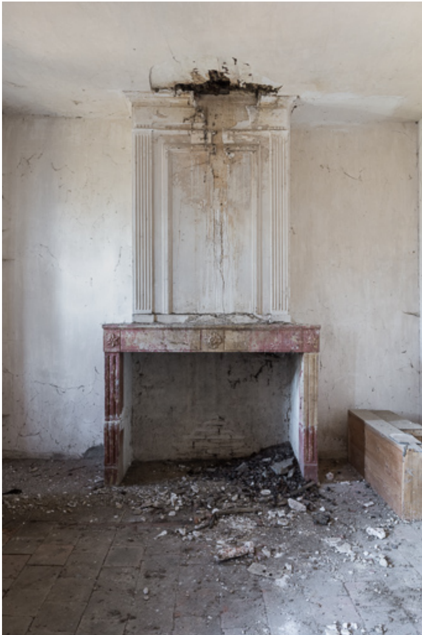
Vue de la cheminée de cette chambre
