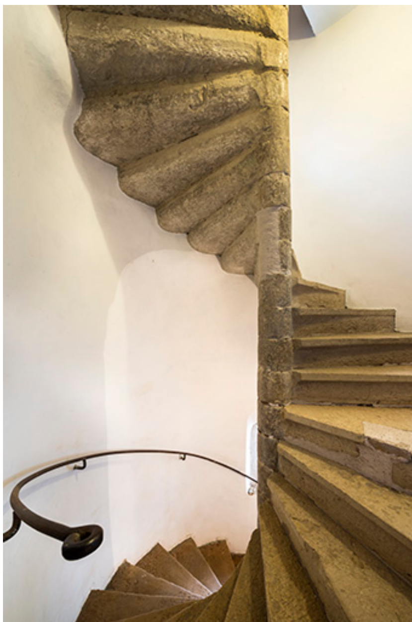
L'escalier à vis dans la tour.
