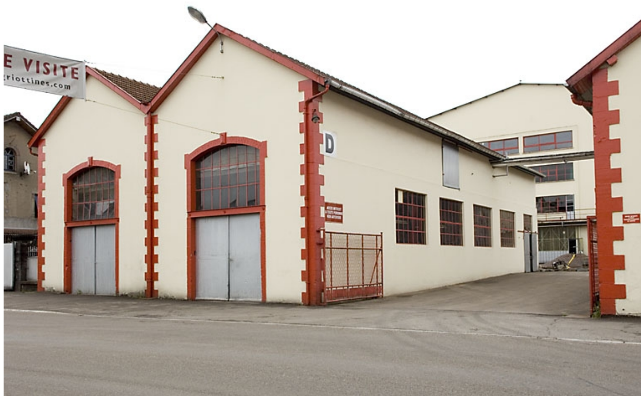
Atelier de réparation. Vue de trois quarts.
