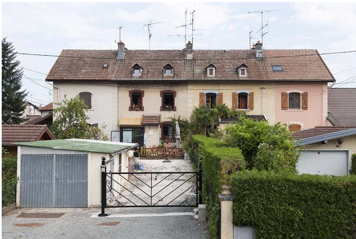
Habitation à 8 logements. Vue de face.
